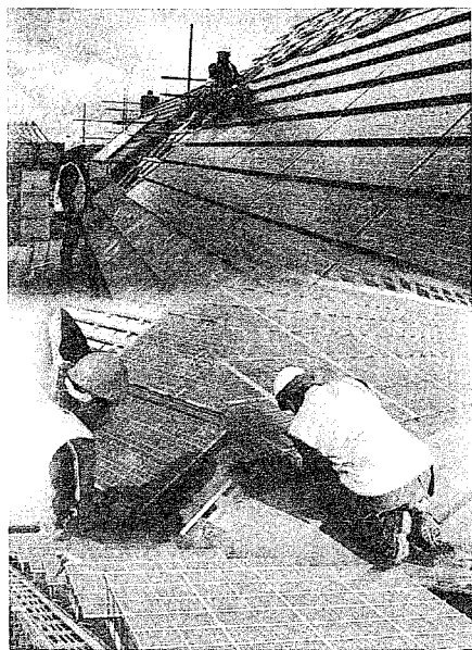
圖 2：太陽光電系統的屋頂安裝技術（斜面式與平台式安裝）
